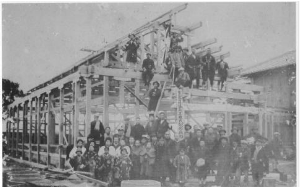
お広前棟上げ当日の写真（昭和6年2月24日）
